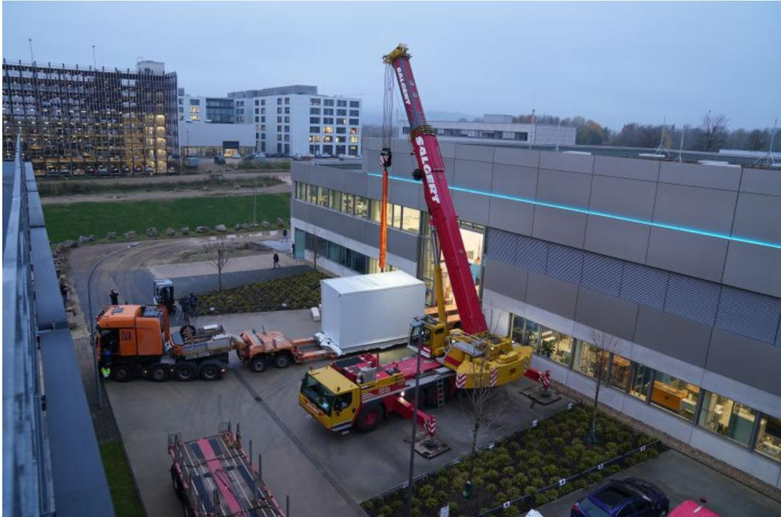
© WZL Anlieferung der 54 Tonnen Bleikammer an der Maschinenhalle des WZL
